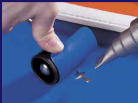
Наварка заплат и другие виды ремонта
